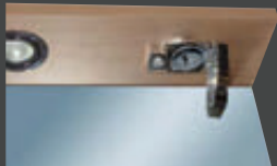
Zásuvka, vypínač, světelná rampa
